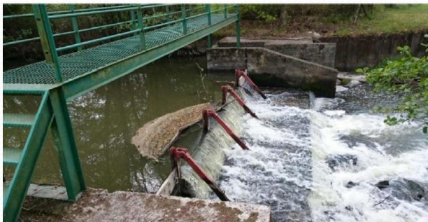
Photographie 7 : barrage de Maisonfort en octobre 2012 : présence des madriers (Suez Consulting, fiche ouvrage – étude de la restauration de la continuité écologique des cours d'eau prioritaires du bassin du Beuvron)
