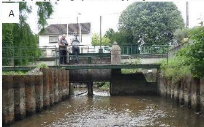
Photographie 7 : barrage de Maisonfort en octobre 2012 : présence des madriers (Suez Consulting, fiche ouvrage – étude de la restauration de la continuité écologique des cours d'eau prioritaires du bassin du Beuvron)
