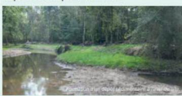
Selon la technique du déblais remblais, les matériaux extraits des berges et des merlons de curage qui subsistaient des précédentes campagnes de travaux hydrauliques ont été redispuestos de façon à former une avancée dans le cours d'eau.
