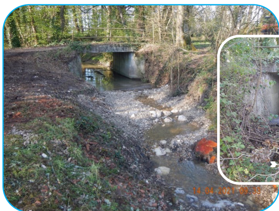
➔ Vue aval/amont du pont
